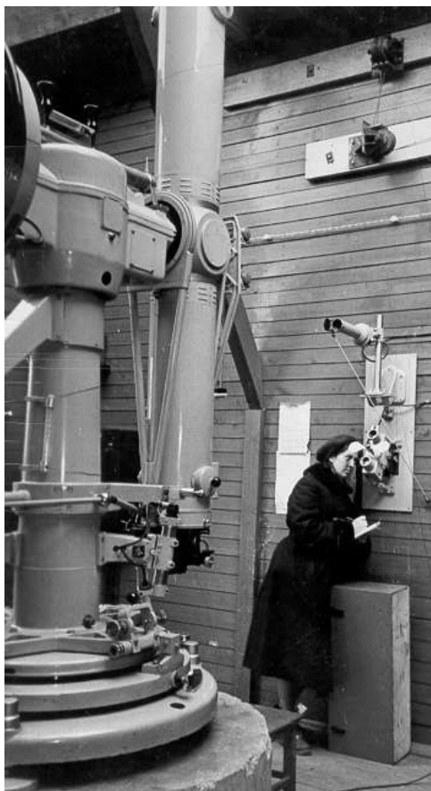
К. С. Мансурова снимает показания уровня зенит-телескопа ЗТЛ-180. 1959 г.
